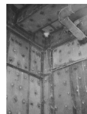
鉄筋とケーブルが露出した施工前水槽
