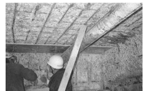
鉄筋とケーブルが露出した施工前水槽
