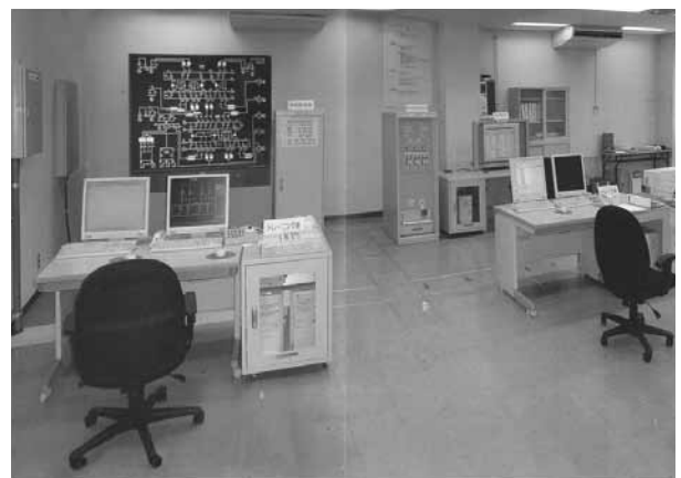
変電所運転シミュレータ全景
