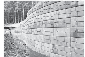
「ポラメッシュ」製品施工完了
