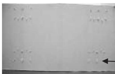
壁裏から見た状態
